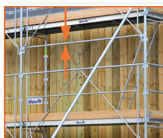
Travée d'accès avec lisse de protection au-dessus du garde-corps.
