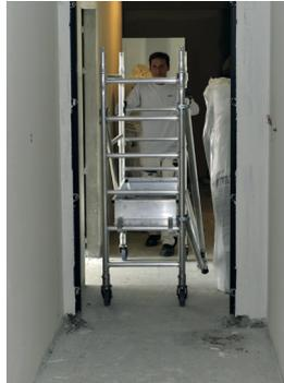
Se glisse aisément dans les portes de largeur de 0,63 m.
